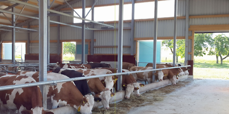
Nackenriegel als kostengünstige Alternative zum Fressgitter.
