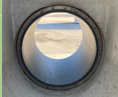
Kunststoffrohre (DN 630) gewährleisten sicheren Gülleablauf
