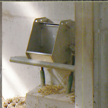
Große Einzelplatztränke mit Schutzbügel.
