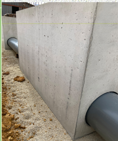
Kunststoffrohre (DN 630) gewährleisten sicheren Gülleablauf
